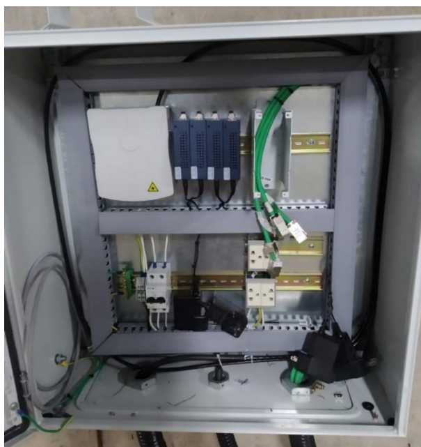
Figura 4 – Detalle de CFAP - Caja de Fijación de Access Point
