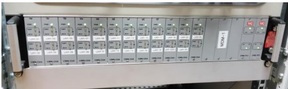
Figura 12 – Rack con módems RS232 del CDA.
